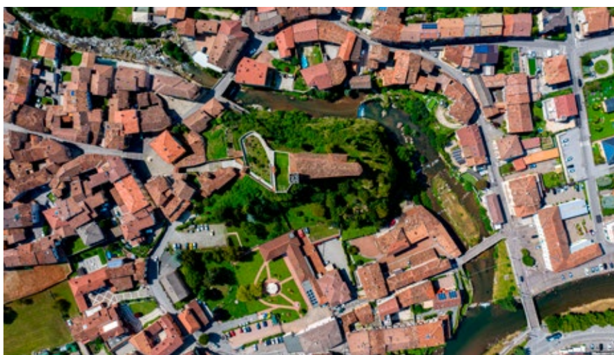
Centro storico nello scatto fotografico di un drone
