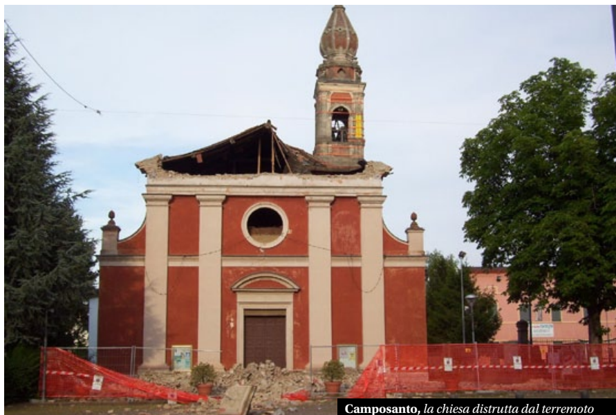
Camposanto, la chiesa distrutta dal terremoto
